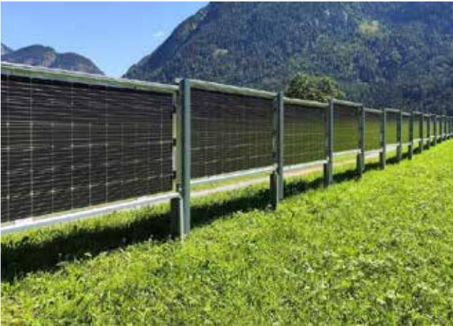
**Fallbeispiel 4: Die Einfriedung wird in Form einer PV-Anlage bis 50 kW ausgeführt**
